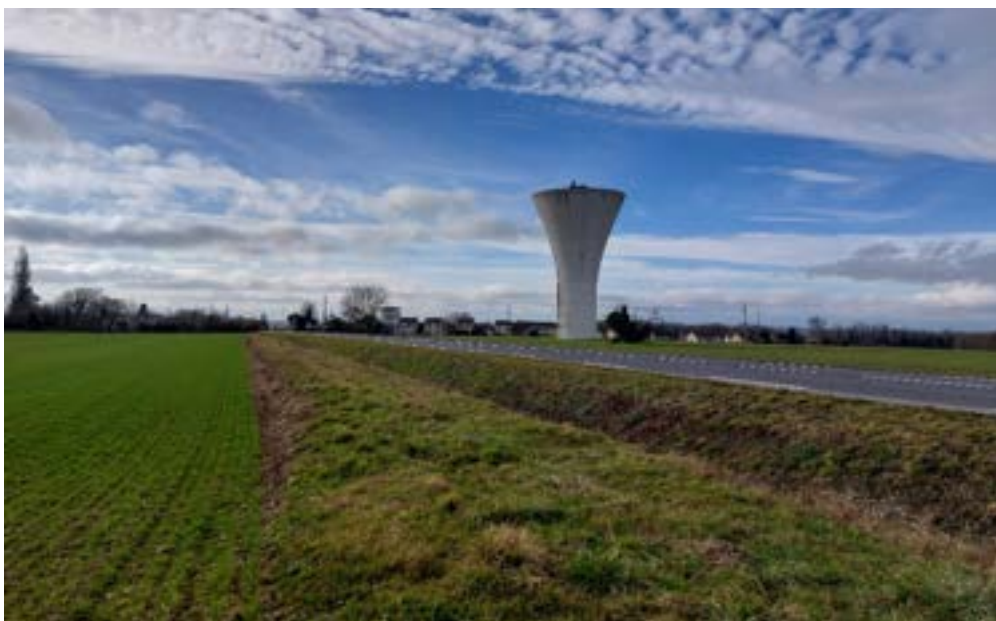
Le château d'eau apporte un repère vertical dans ce plateau agricole – Source SAFER Grand -Est
