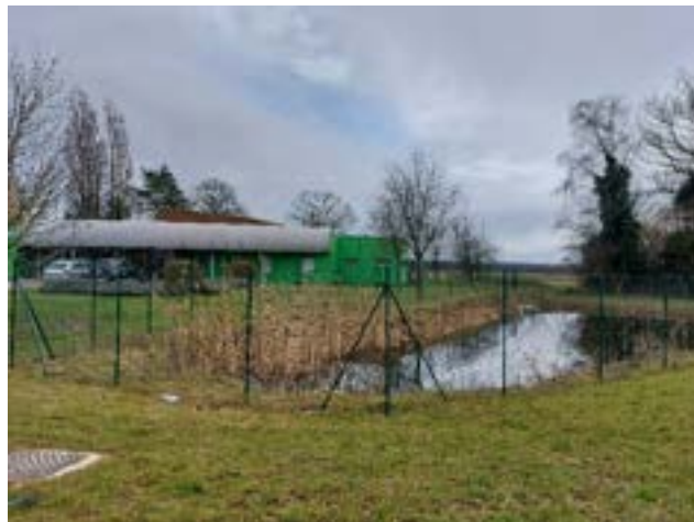
Bassin de rétention des eaux pluviales récent – Source SAFER Grand-Est
